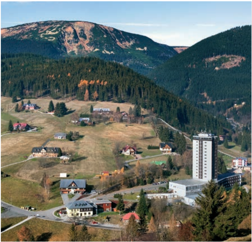
Pec pod Sněžkou. Velká pláň se Studniční horou. Foto: Ing. Ctibor Košťál
