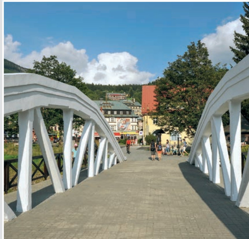
Špindlerův Mlýn. Bílý most přes řeku Labe z roku 1911. Foto: Ing. Ctibor Košťál
