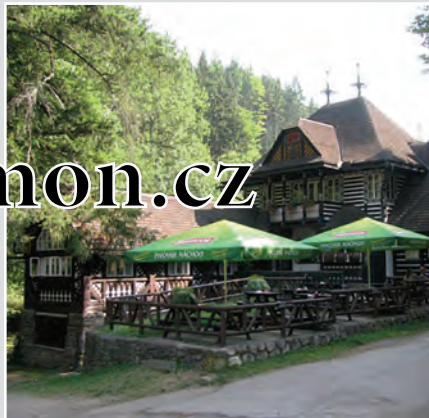
Kulturní památka turistická chata Peklo neboli Bartoňova útulna, postavená dle návrhu Dušana Jurkoviče, stojí na místě historického vodního mlýna na řece Olešence nad soutokem s Metují.
