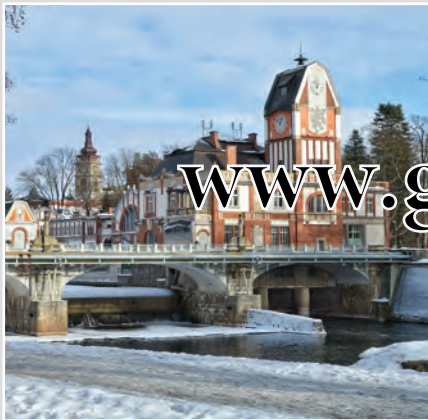
Vodní elektrárna Hučák byla na Labi v Hradci Králové vystavěna v letech 1909 až 1912. Budovu v secesním stylu navrhl architekt František Sander.
